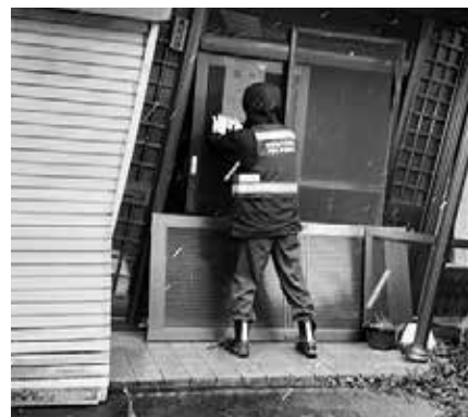
【建築班】応急危険度判定調査
