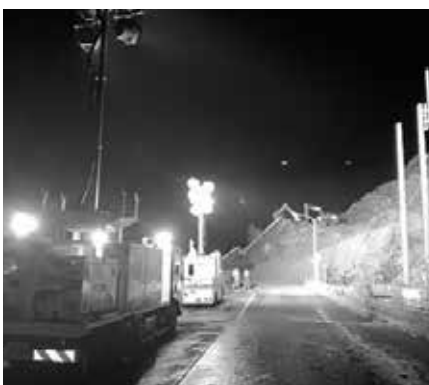
【照明支援班】照明車による道路啓開補助
