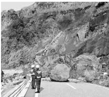
【砂防班】崩落箇所の被災状況調査
